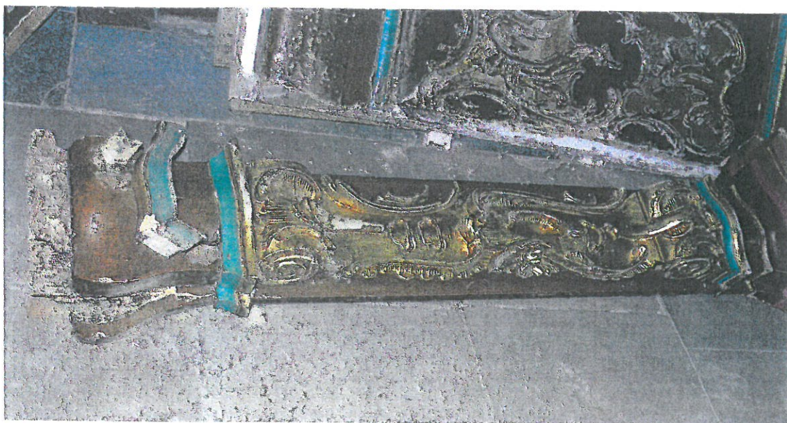
Fot. 4. Element konstrukcyjny z widocznymi zniszczeniami przed konserwacją
